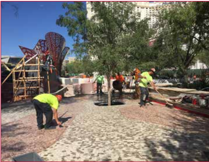
Mischen und Verfugen | Mixing and grouting
