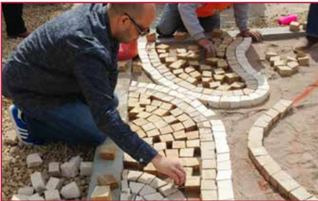
Akribischer Einbau des Mosaikpflasters Acribic installation of mosaic paving stones
