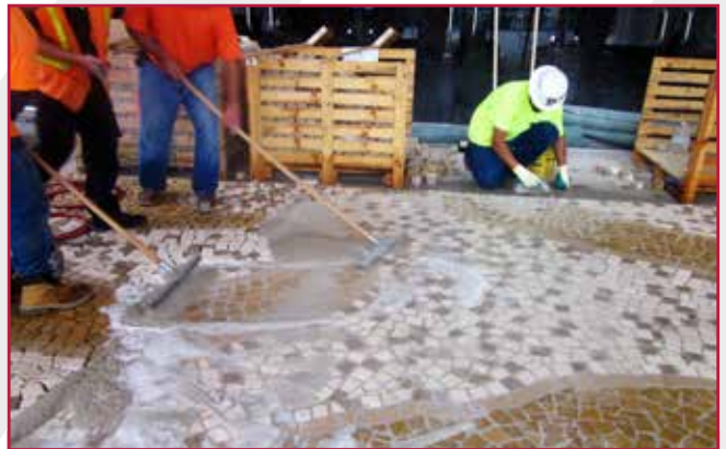
Verfugung mit ROMPOX® - D2000 Grouting with ROMPOX® - D2000
